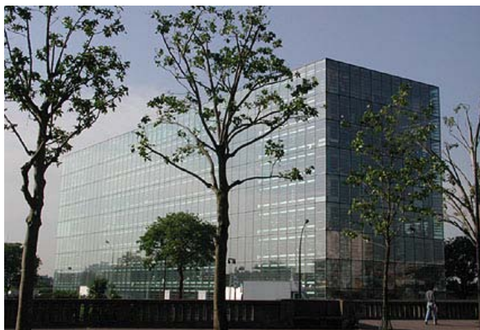
Hôtel Industriel, Paris, arhitect Dominique Perrault
